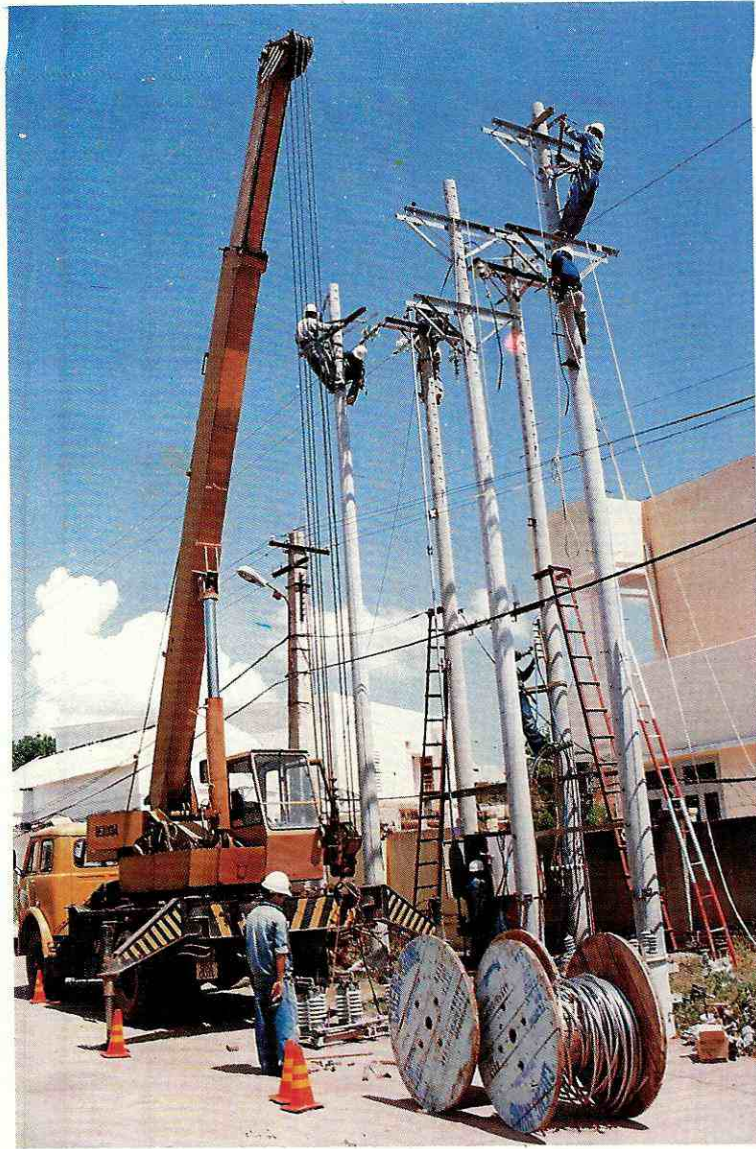
Công nhân điện lực đang thi công đường dây tải điện.
